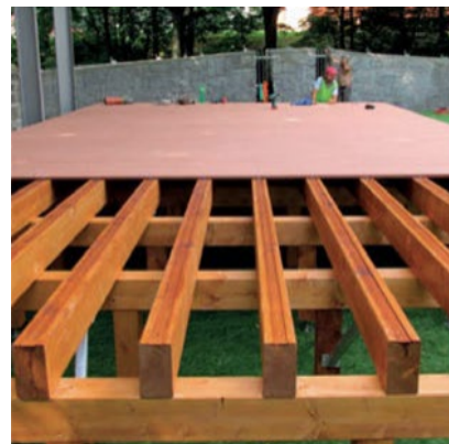
muu kandev konstruktsioon
